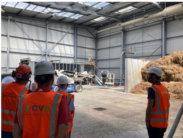
Bâtiment de stockage des matières à traiter (effluents d'élevage à droite) équipé d'un système de traitement de l'air
