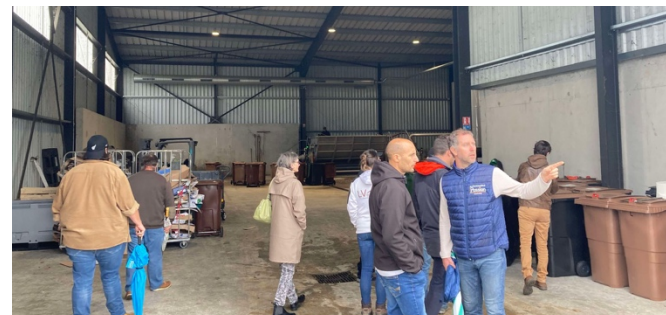
Bâtiment de stockage des matières à traiter équipé d'un système de traitement de l'air
